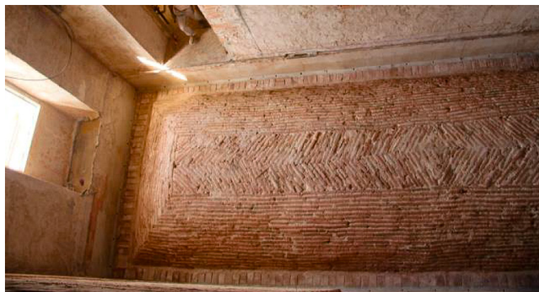
Fig. 58a, 58b, 58c. Foto di Palazzo Camponeschi durante i lavori di restauro realizzati a seguito del terremoto del 2009: consolidamento delle volte in mattoni con fibre di vetro.
